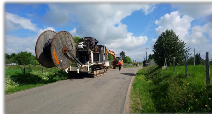
Exemple de chantier d'enfouissement de câble le long d'une voirie (source : scieydd)
