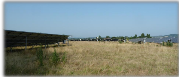
Exemples d'enherbement sous structures photovoltaïques (crédit photo Ectare)
